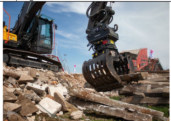
Ob Bauschutt oder Bahnschwellenaufbereitung – auf dem Stand von Kurz, Moerschen und ARJES gab es jede Menge Live-Action zu erleben
