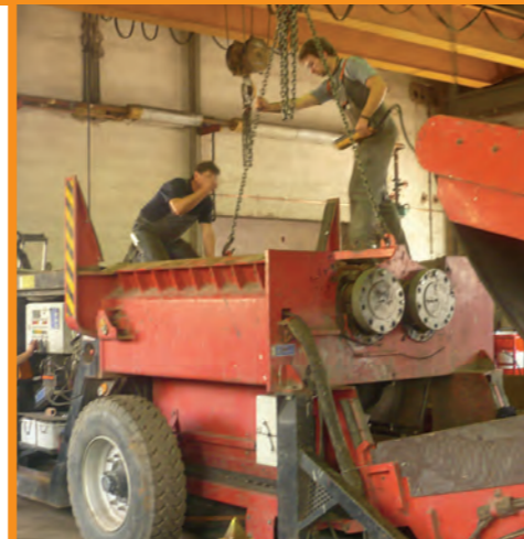
Wechsel von Werkzeugwellen
